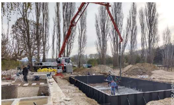
Coulage du radier de la piscine. Structure en panneaux acier boulonnés et maintenus par les jambes de force.
